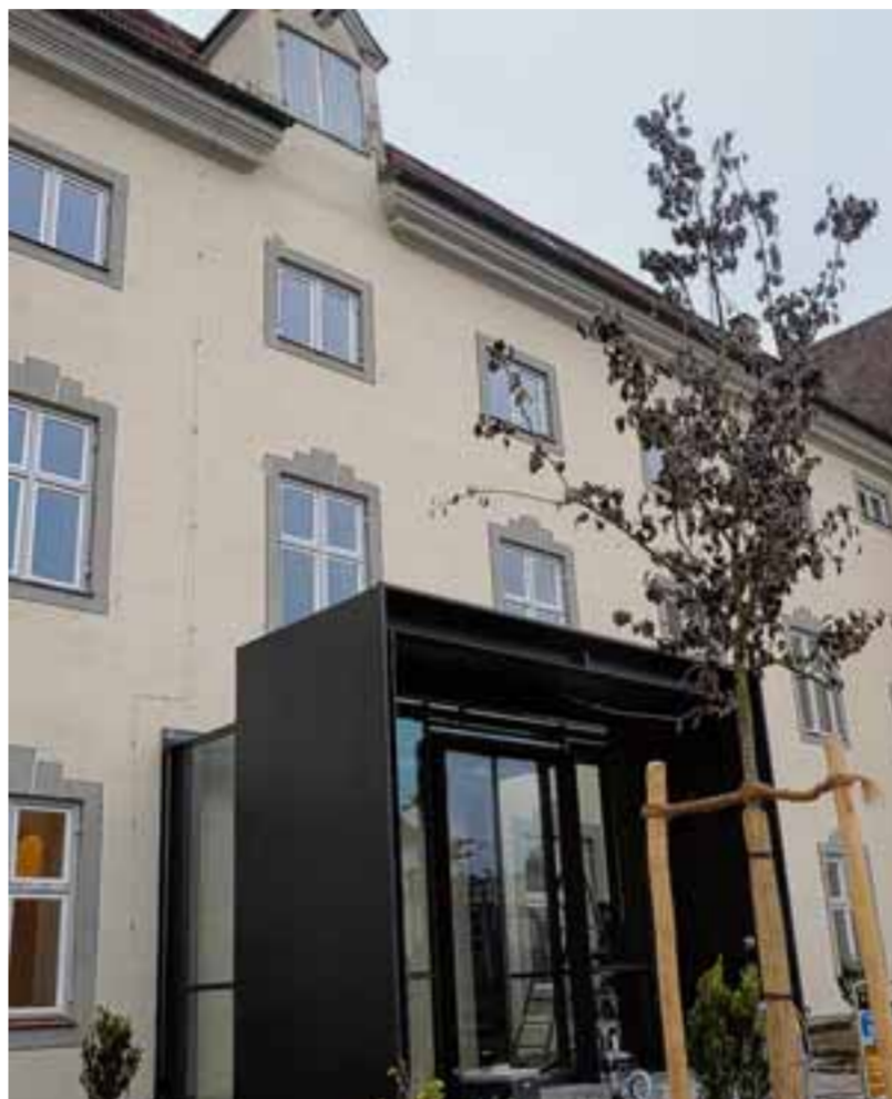
Das Kloster Holzen ist zu einem modernen Tagungshotel ausgebaut worden. Fünf Millionen Euro wurden investiert. Foto: Andreas Lode
