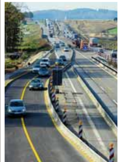
Auf Höhe Neusäß verläuft das provisorische Teilstück der A8. Foto: Marcus Merk
